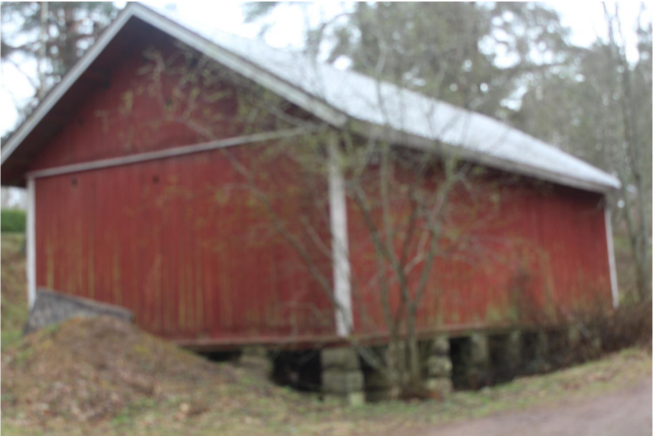
Varastorakennus, poistuu aikanaan käytöstä ja puretaan kun rakennuksen kunto heikkenee.
